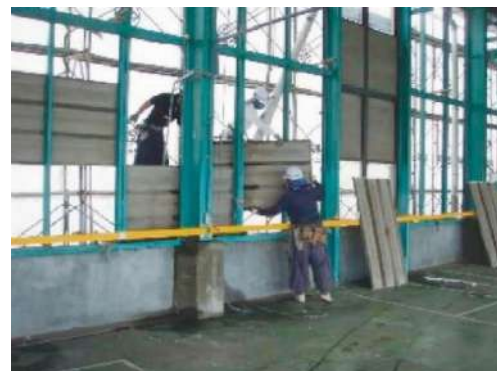
壁石綿含有成形板取外し
