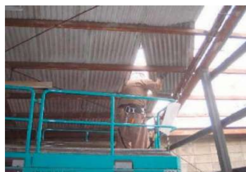
屋根スレート取外し
