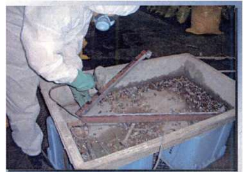
図4.11.17 掻き落とし除去作業の例
