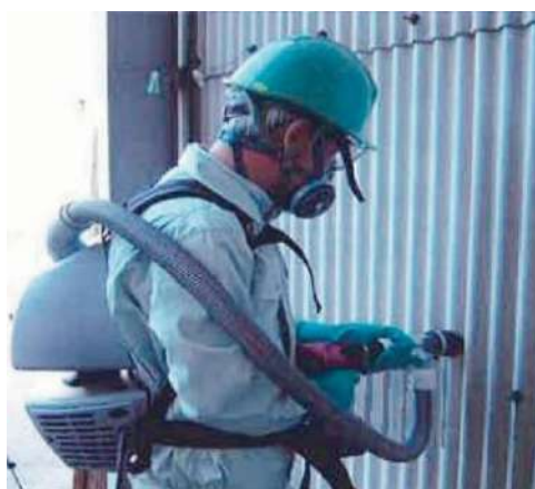
図4.11.7 機械工具による切断例
