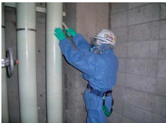
図 4.8.2 保温材被覆撤去
