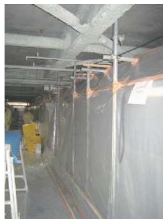
図 4.7.6 同上施工区画 (内部側、右外側が車路)
