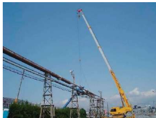
図 4.10.5 配管の吊り下ろし
