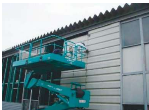
壁金物取外し
