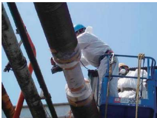
図 4.10.4 切断箇所の保温材除去と養生
