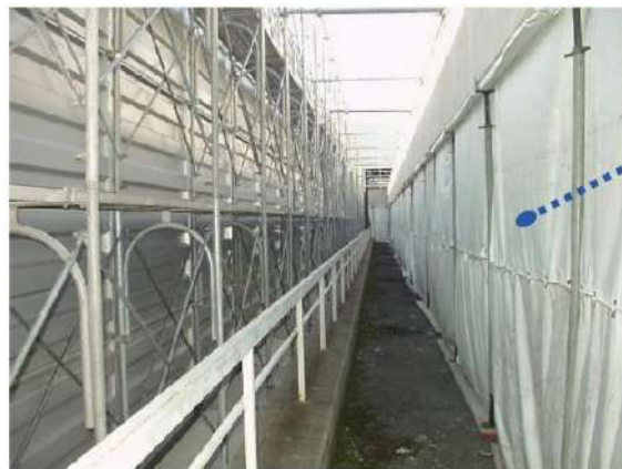
図 4.7.19 外壁開口部の飛散防止措置（開口部全面に防火シートを張った）
