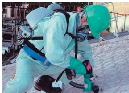
粉じん回収（高性能真空掃除機）
