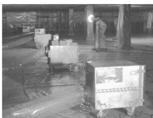
図 4.7.45 集じん・排気装置への排気ダクトの取付け
