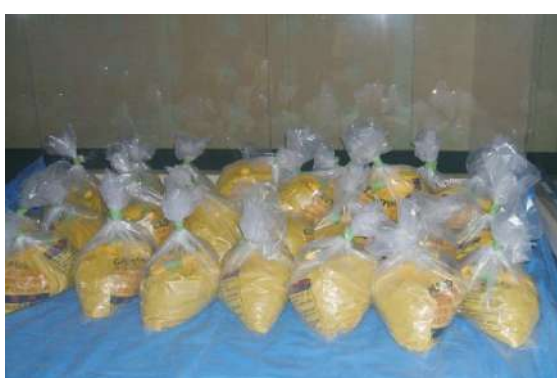
図 4.7.78 除去した石綿廃棄物の保管
