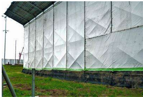
周囲への飛沫飛散防止養生例（外部）
