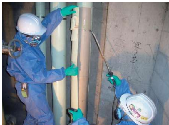
図 4.8.3 保温材の湿潤化→取り外し
