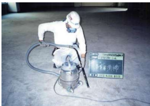
図4.11.21 清掃 高性能真空掃除機使用例
