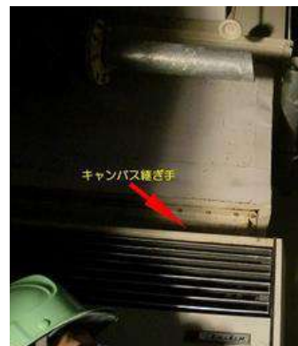
（参考資料）写真 6－11 キャンバス継ぎ手
