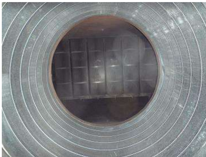
写真Ⅲ－５ 吸込ダクト内部（φ1,300）の例
