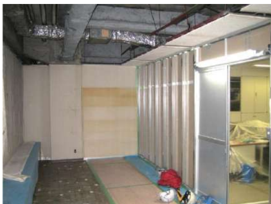
図 4.7.2 テナントビルの施工区画 （内部側）
