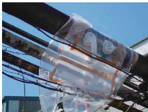
図 4.10.3 切断箇所へのグローブバッグ取付
