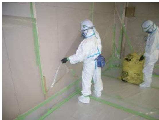
図 4.7.91 隔離シートの撤去
