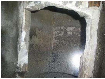
(参考資料) 写真 6-3 ハイスタック 煙突断熱材
