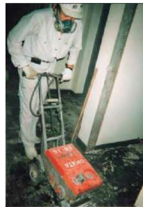
図4.11.12 石綿含有ビニル床タイルの 除去例
