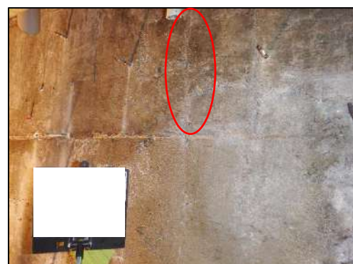
図4.15.10 取り残しの除去の確認
