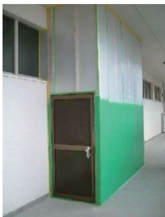
図 4.7.7 教室前廊下の施工区画 (外部側)
