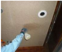
（飛散抑制剤にて湿潤化）
