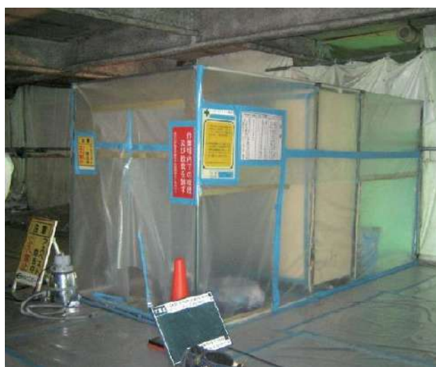
図 4.7.28 セキュリティゾーン外観
