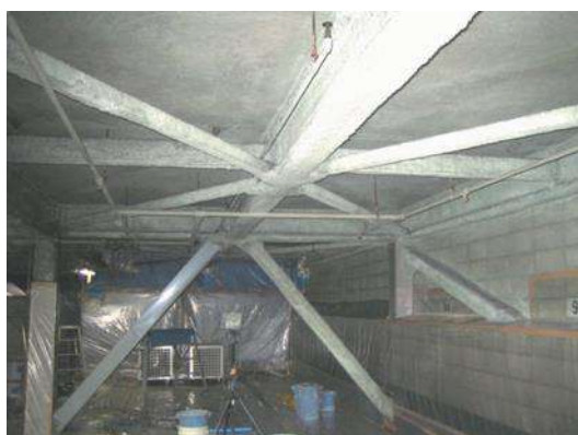
図 4.7.5 同上施工区画の内部側
