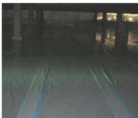
図 4.7.11 床面の負圧隔離養生例（2重張り）
