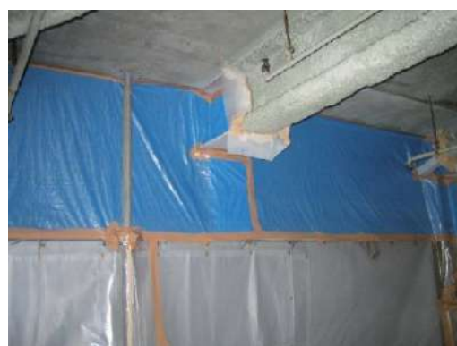
図 4.7.12 壁面の負圧隔離養生例（作業場内側）
