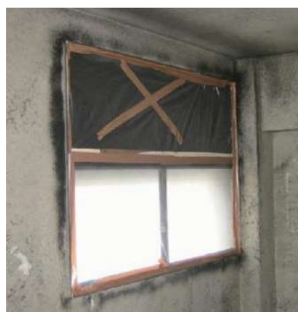
図 4.7.14 窓、換気口の負圧隔離養生例
