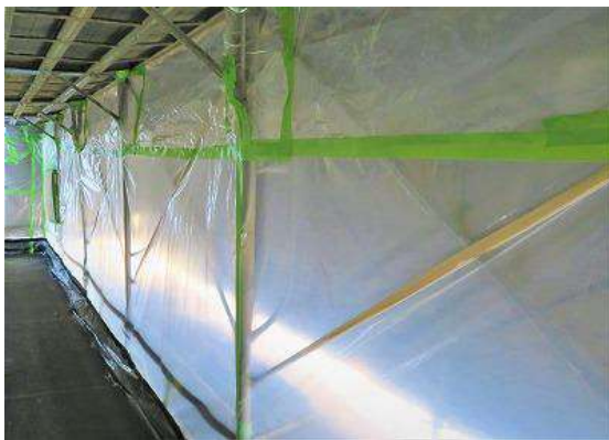
周囲への飛沫飛散防止養生例（内部）
