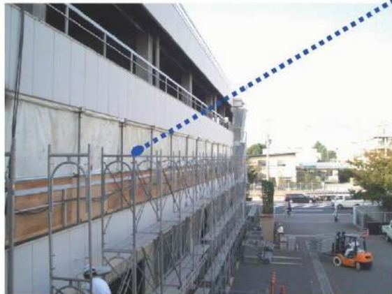
図 4.7.18 外壁開口部の飛散防止養生（既存手すりを活用し、防火シートとベニヤ板を使用して負圧隔離養生の破損を防止）
