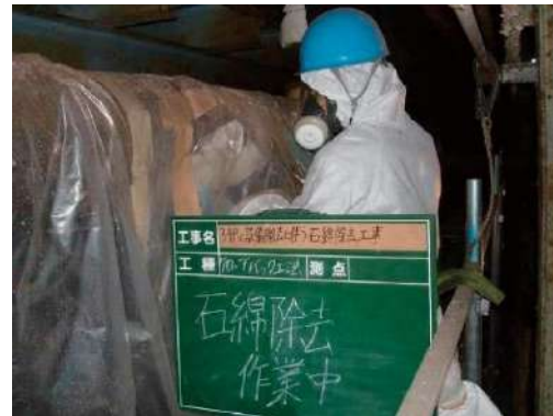
図 4.10.9 石綿除去作業中 1
