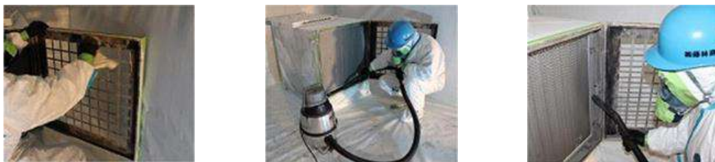
図 4.7.83 HEPAフィルタ等の清掃
