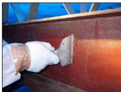
図4.15.5 再付着した石綿の除去
