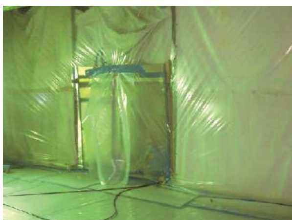
図 4.7.13 壁面の負圧隔離養生例 (作業場内側 負圧化のため内側へはらんでいる)
