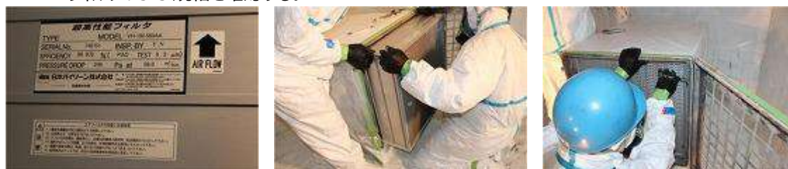
図 4.7.86 フィルタの取り付け
