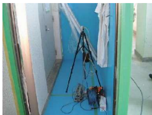
図 4.7.8 同左施工区画 (内部)
