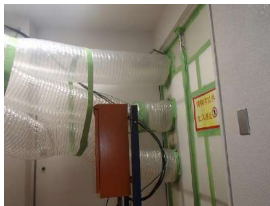
図 4.7.47 排気ダクトと隔離の取合い （隙間を完全に封鎖）
