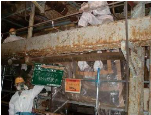
図 4.10.8 グローブバッグ取付作業中
