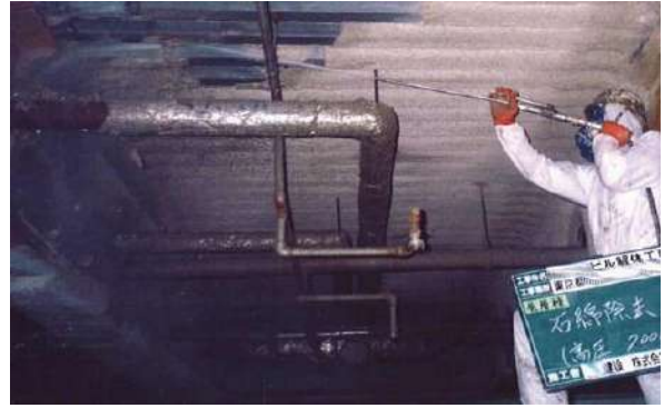
図 4.7.59 ウォータージェット工法の例
