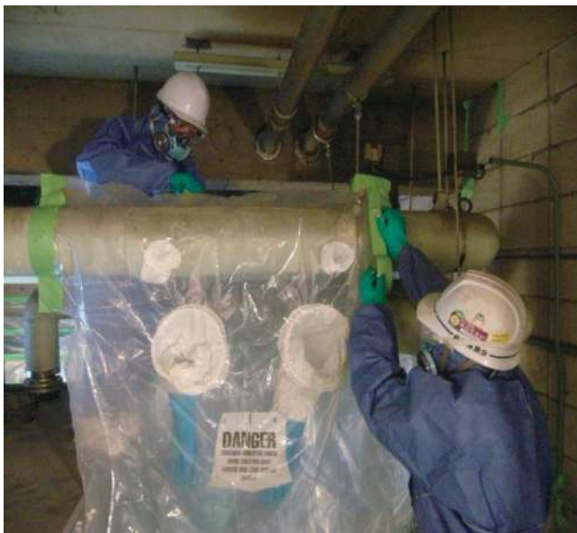
図 4.10.1 グローブバッグの例
