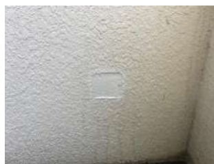
(固化および簡易補修後)
