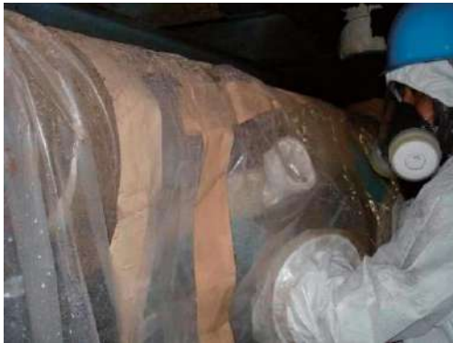
図 4.10.10 石綿除去作業中 2
