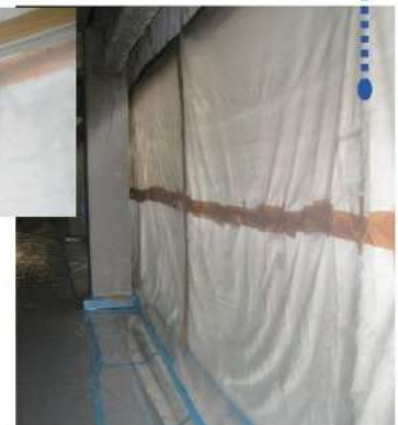
図 4.7.22 開口部の負圧隔離養生（防火シートの内側をプラスチックシート等で養生）
