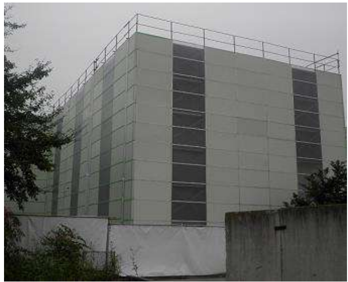
図 4.7.33 防音パネル／採光防音パネル施工例
