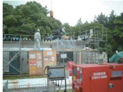
図 4.10.17 折板をはがしているところ
