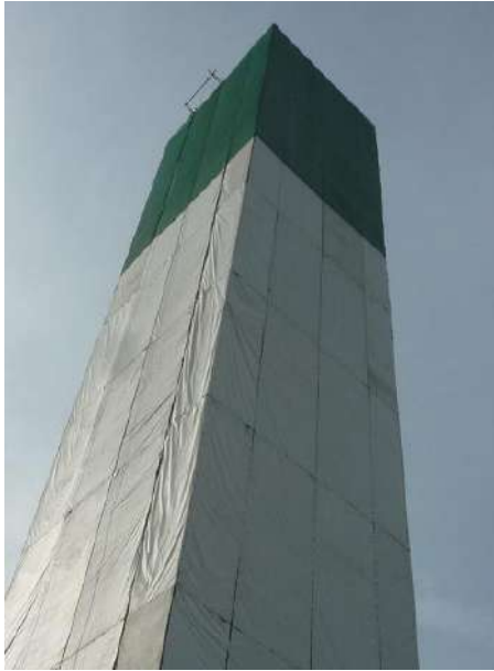
図 4.7.32 垂直ネットによる煙突頂部養生例
