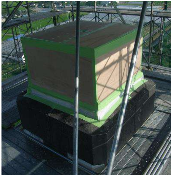
図 4.7.34 煙突開口部養生例
